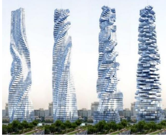
شكل 7: يوضح برج دافنشي هو برج ديناميكي لناطحة سحب دوارة صممها المهندس المعماري الإيطالي ديفيد فيشر David Fisher. بارتفاع 420 متراً، الأبراج قادرة على الدوران 360 درجة بشكل مستقل حول محور مركزي. المصدر: https://ar.socialdesignmagazine.com/mag/architettura/david-fisher-dynamic-tower-qil-grattacielo-ruotante/
