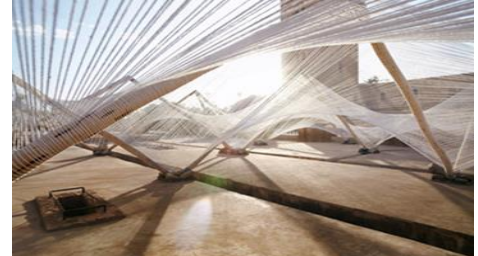
شكل (44) جناح بركاو Barkow Leibinger المصنوع من نسيج القطن ينتهي بشكل متكرر دون أن يتشقق [24]https://www.designingbuildings.co.uk/wiki/Architectural_fabrics
