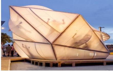
شكل (43) يوضح جناح إنديسا MARGEN-LAB المصنوع من هيكل من الكتان [21]https://www.archdaily.com/960205/cloth-and-linen-walls-translucent-and-weightless
