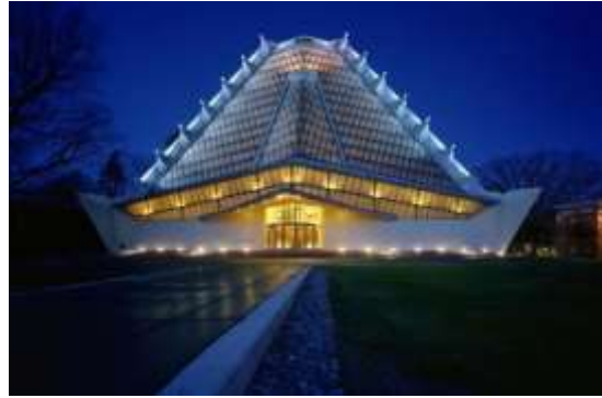
شكل (16) منظر خارجي كنيسة التوحيد فرانك لويد رايت Frank Lloyd Wright) تم بناؤه من 1905-1908 ويأخذ المبني شكل السفينة (سفينة نوح)
