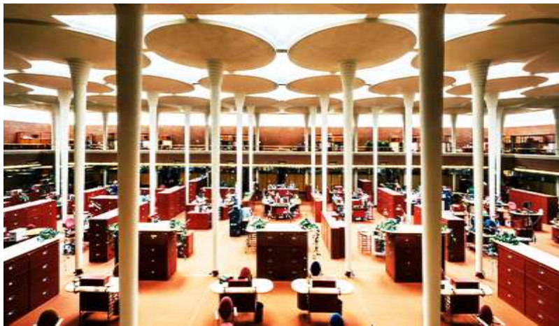
شكل (20) سقف من الزجاج المنفوخ ورقائق النحاس، قاعة العمل في المبنى الإداري لشركة جونسون SC Johnson من تصميم فرانك لويد رايت، 1951 م
