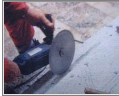
(شكل ٢٢ ) استخدام الصاروخ الكهربائي وأسطوانات القطع ( الفيديا ) لتحديد حواف الرموز والنزول بها للعمق المطلوب
