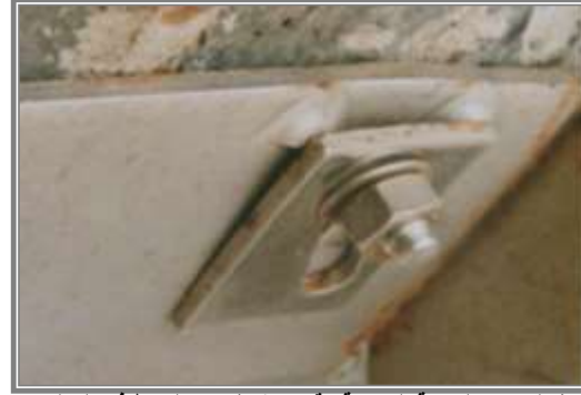
(شكل ٤٢) الزاوية المعدنية وقد حدث نفوس ملحوظ في الضلع الأعلى نتيجة تحميلها لضغط وزن من الكتل الجرانيتية
