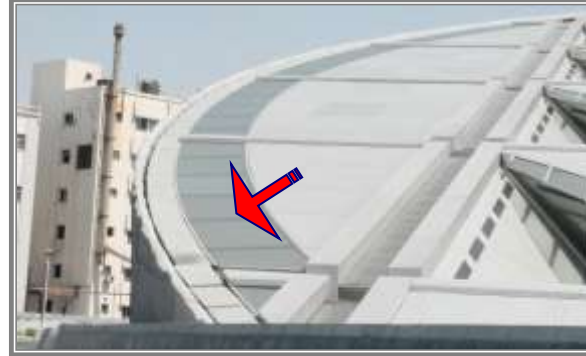
(شكل ٤٣) الفراغ الواقع بين مسطح الخرسانة والكتل الجرانيتية ويصل إلي ١٥ سم تقريباً ، حيث يعمل على تقليل نسبة الرطوبة التي تؤثر على الزوايا المعدنية ، وذلك بنظرية تيارات حمل الهواء .
