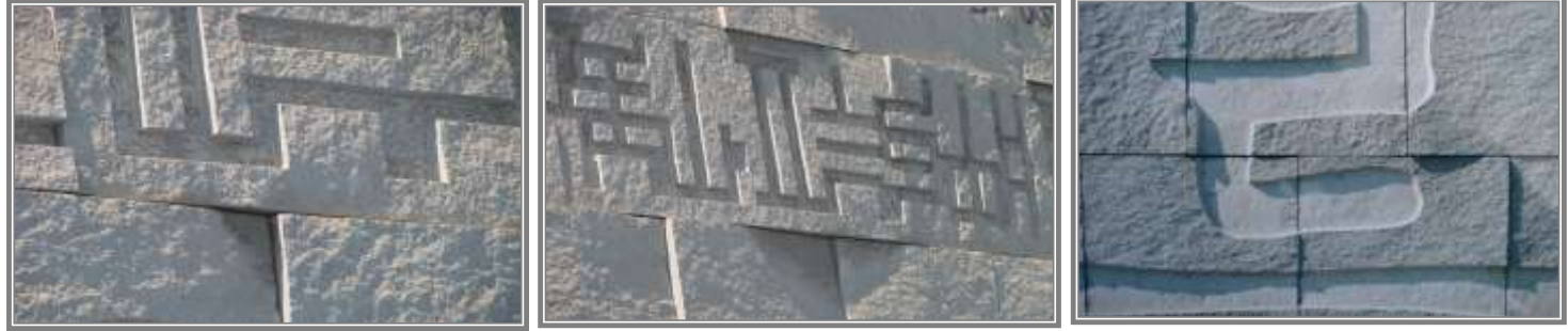
(شكل ٨ ب ، ج ) يوضح ظهور خطوط وظلال حادة رأسية وأفقية بين كل كتلة وأخرى نتيجة عدم انتظام سمك الكتل خاصة من الحواف ويتضح ذلك جيداً تبعاً لزاويا سقوط أشعة الشمس
