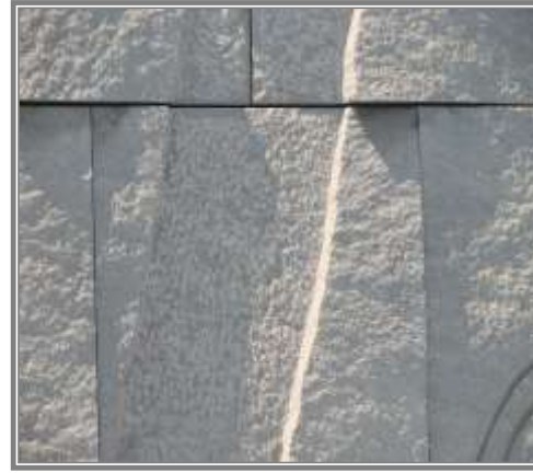
(شكل ١٣) نلاحظ التنوع اللوني والملمس بين سطح الرمز ومسطح الجدارية نتيجة استخدام إزميل المسمار اليدوي في مسطح الرمز
