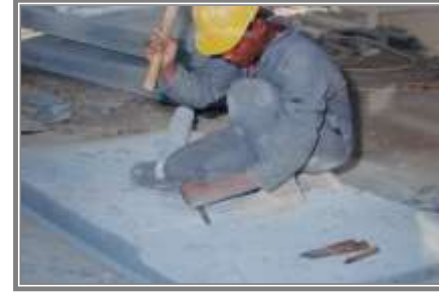
(شكل ٢٣ A) استخدام الأزاميل المسمار يدوياً في النحت للنزول للمستوي المطلوب وإحداث ملمس خشن مميز في مساحات بعض الرموز
