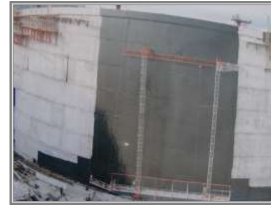
(شكل ٣٠ A B) طلاء السطح الخرساني بطبقة من البيتومين كمادة عازلة قبل بداية مراحل الإنشاء
