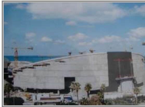
(شكل ٣٠ A B) طلاء السطح الخرساني بطبقة من البيتومين كمادة عازلة قبل بداية مراحل الإنشاء
