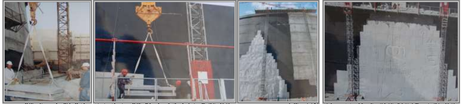
(شكل ٣٢ A ,B ) طريقة تحميل ونقل الكتل بواسطة وابرات مرنة للحفاظ على حواف الكتل من
