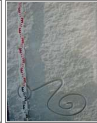
(شكل ٢٩) رمز قد استخدم الأزميل المبسط مع مطرقة ضغط
