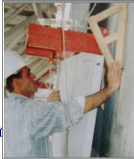
(شكل ٣٦) المثلثات الخشبية لتحديد المسافة بين الكتلة والمسطح الخرساني
