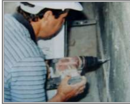
(شكل ٣٥) عمل ثقوب في المسطح الخرساني لتثبيت الفيشر
