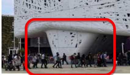
صورة (١٨) لأعمدة المبني الضخمة من الخارج
