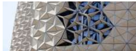
صور (٢٦،٢٥) نخاريب النخيل و هي في حركة ديناميكية لتشكل مظهر تبعاً لبرنامج الحاسب الآلي في حالة الرغبة في تعديل البرنامج من تتبع حركة الشمس إلي تكوين شكل محدد
