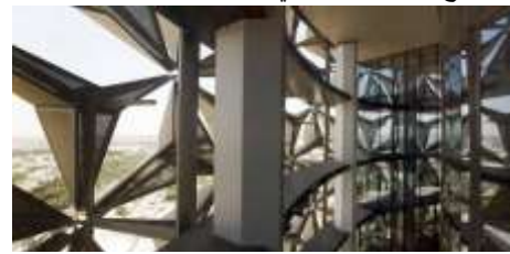
صورة (٢٧) نخاريب النخيل المفتوحة من الداخل
